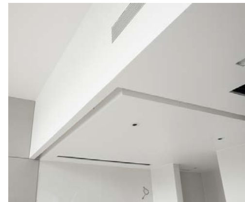
prefabricage montage en afwerking
