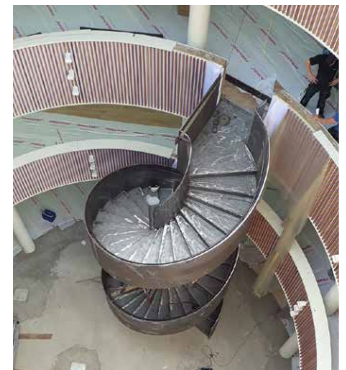
In de vide is een uitnodigende stalen wenteltrap geplaatst.
